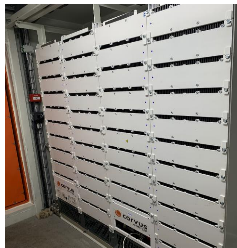
Рисунок 4 – Розташування АБ в контейнері
